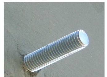
19 mm lang muss die Gewindestange auskragen; beim Vordach mit Dachneigungskeil sogar 24 mm
