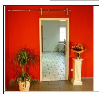
1) Anwendungsbeispiel: So sitzt die Laufschiene mit Laufwagen an richtiger Position. Zum Schluss wird die Glasscheibe befestigt.
