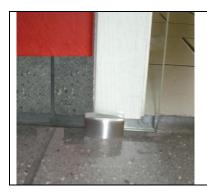
12) Als letzten Schritt montieren Sie nun die Bodenführung. Hierfür stellen Sie auf der Unterseite die Glasdicke ein (10 mm) und schrauben diese dann mit 2 Schrauben in den Fußboden.
