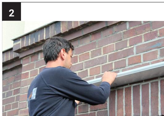
Legen Sie das Profil an der Linie an und markieren die Bohrlöcher mit einem Stift.
