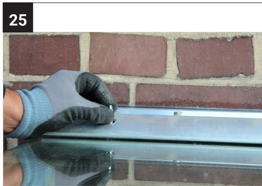
Setzen Sie die Sicherungsstifte in das Profil und Glas ein.
