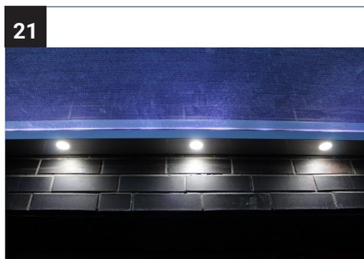
Setzen Sie die LED-Strahler in die vorgebohrten Löcher der Profilabdeckung (untere) ein.
