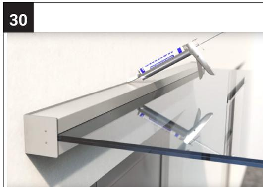
Silikonieren Sie den Spalt zwischen Wand und Profil. Damit stellen Sie sicher, dass kein Wasser hinter dem Profil herlaufen kann.
