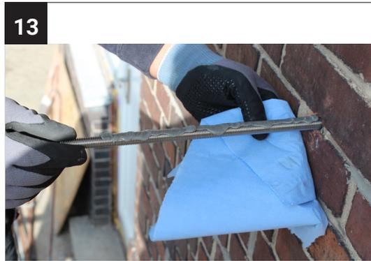
Tragen Sie Kleber auf die Gewindestange auf und drehen die Gewindestange dann langsam so tief wie möglich in das Bohrloch ein.
