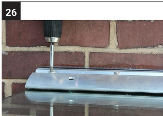
Schrauben Sie das obere Profil nun fest. Arbeiten Sie dabei von einer Seite zur anderen. Ziehen Sie die Schrauben abschließend mit 20 Nm fest an.
