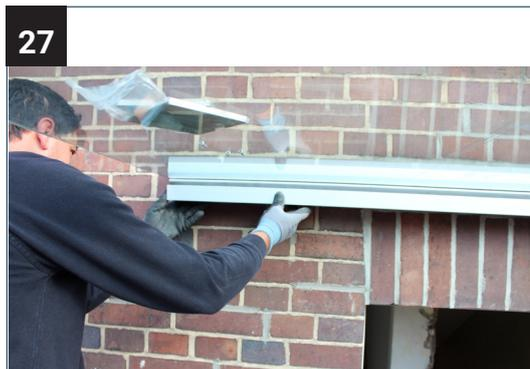
Klipsen Sie die Abdeckprofile auf den Profilkörper. Die Reihenfolge für oben oder unten spielt keine Rolle.
