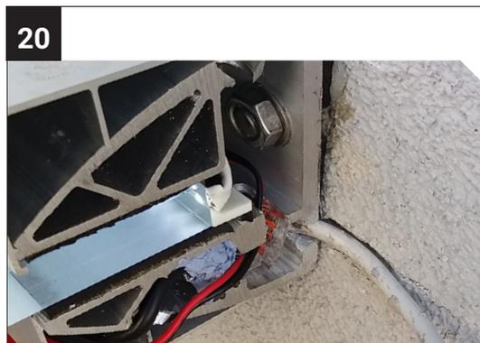
Schließen Sie den Trafo gemäß der beiliegenden Bedienungsanleitung am Strom an.
