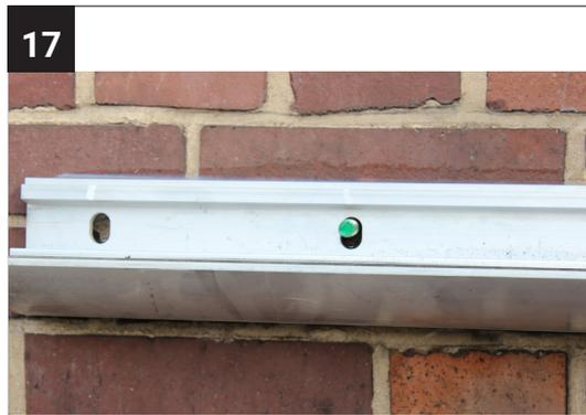
Montieren Sie zuerst die untere Profilschiene. Klopfen Sie das Profil mit einem Gummihammer fest, damit es bündig an der Wand sitzt.
