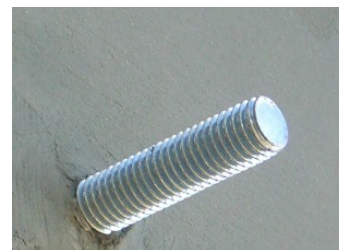
22 mm lang muss die Gewindestange auskragen; beim Vordach mit Dachneigungskeil sogar 28 mm
