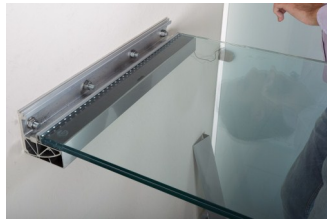
Gummiauflage muss schmutzfrei sein
