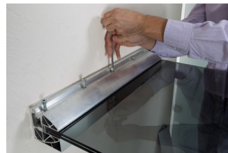
Fixierung mit 6er Inbusschlüssel
