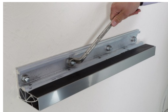
Fixierung mit 19er Maulschlüssel
