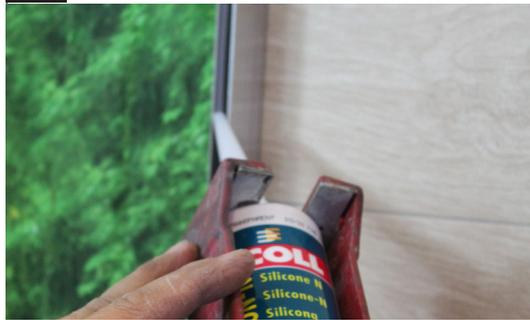
Ziehen Sie gleichmäßig eine Klebeschicht auf die U-Profile an der Wand mit der Silikonpistole ein.
