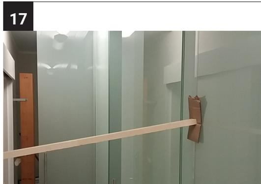
Bei sehr hohen und breiten Gläsern ist eine Fixierung durch Zug oder Druck hilfreich. Beispielsweise mit Holzbalken, die weich abgepolstert werden.
