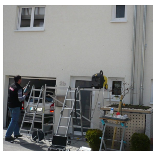
Alu-Gerüst erleichtert die Montage
