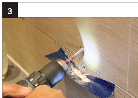
Bohren Sie nun die Löcher in die Wand und saugen dabei den Bohrstaub ab.
