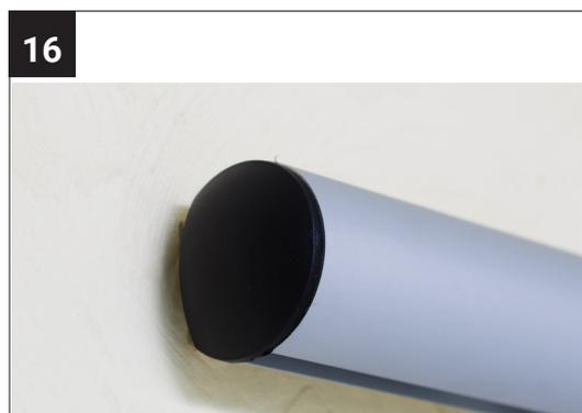
Klipsen Sie die Endkappen an den Laufschienenprofilenden auf.
