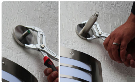
Festdrehen der Gewindeteller mit einer Greifzange
